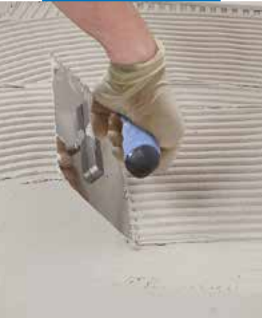
Keraflex Extra S1 felhordása fogazott simítóval
