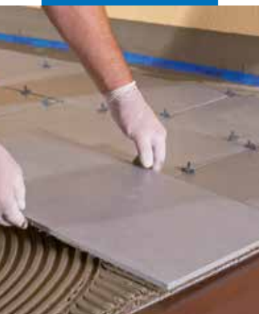
Porcelán lapok fektetése meglévő padlóburkolatra Keraflex Extra S1-el
