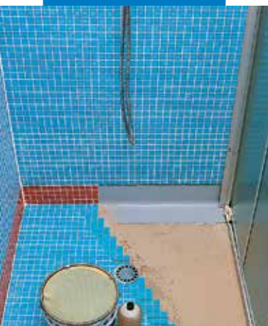
Vízszigetelés és fektetés előregyártott zuhanyzóblokkba
