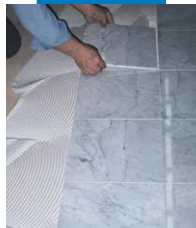
Carrarai márvány ragasztása fa aljzatra fehér Keralastic-kal
