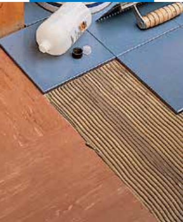
Ragasztás meglévő PVC burkolatra
