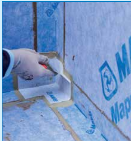
MAPEGUARD IC elhelyezése a belső sarokban MAPEGUARD WP ADHESIVE-vel
