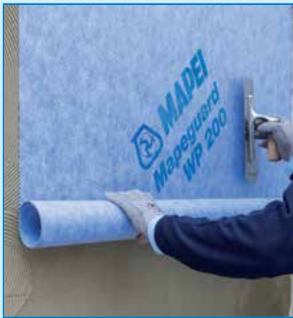
A MAPEGUARD WP 200 első lemezének elhelyezése
