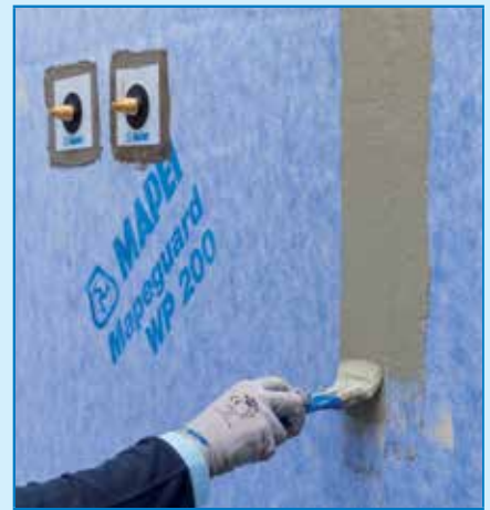
MAPEGUARD WP ADHESIVE felhordása a MAPEGUARD ST előtt a két csatlakozó lemez szigeteléséhez
