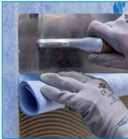
A MAPEGUARD WP 200 második lemezének elhelyezése
