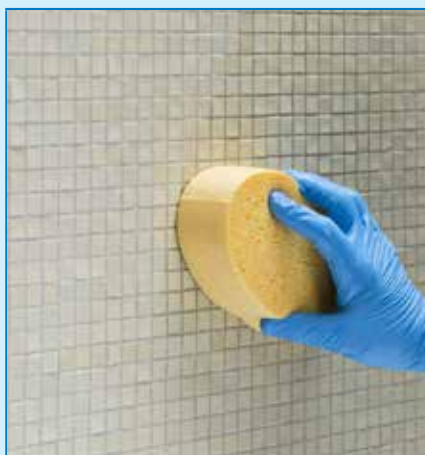
Fugahézagok tisztítása és felületképzése kemény cellulóz szivaccsal
