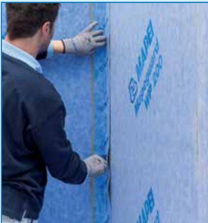
MAPEGUARD ST elhelyezése a MAPEGUARD WP ADHESIVE-re
