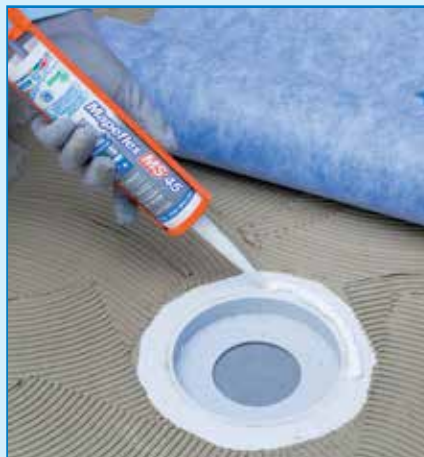
MAPEFLEX MS 45 bedolgozása a lefolyó körül
