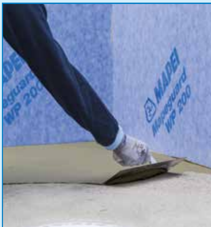
Cementkötésű burkolatragasztó felhordása
