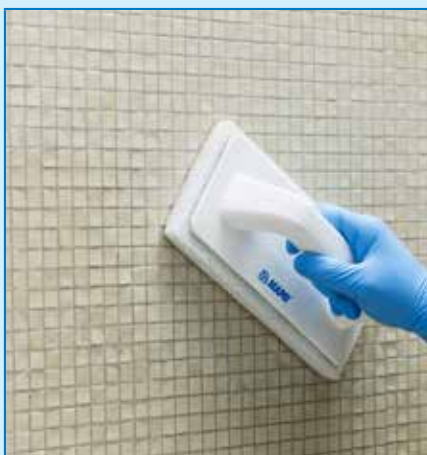
Üvegmozaik letisztítása nedves Scotch-Brite® filccel
