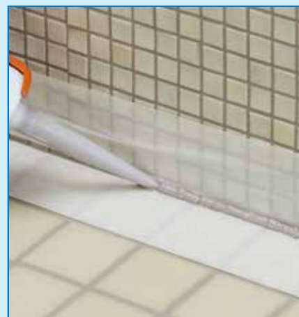
Tömítő bedolgozása minden hajlatba
