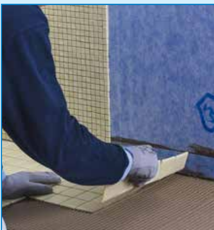
Burkolat fektetése cementkötésű ragasztóval
