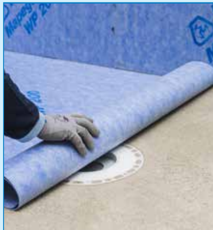
A lemez előzetes elhelyezése a lefolyó pont bejelölése érdekében
