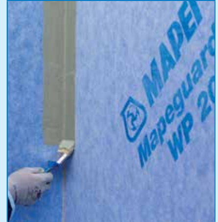
MAPEGUARD WP ADHESIVE felhordása a MAPEGUARD ST előtt a két csatlakozó lemez vízszigeteléséhez
