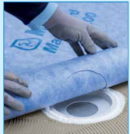
MAPEGUARD WP 200 fektetése
